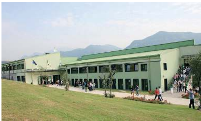
Sul lago di Garda. Al Liceo Fermi di Salò cantieri per 400mila euro
