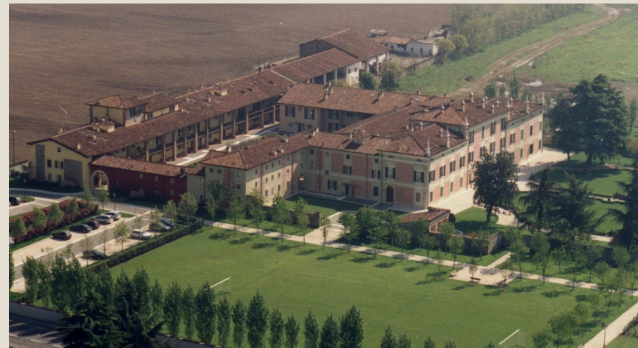
Recupero complesso monumentale La Baitella di Castegnato
