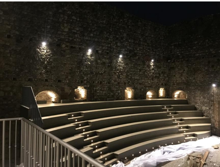
Restauro e Valorizzazione del medievale Castello - recetto di Padenghe sul Garda. Particolare della gradinata del nuovo TEATRO nel recinto del Castellino
