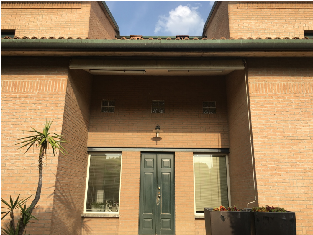
Manerbio (BS) realizzazione abitazione unifamiliare
