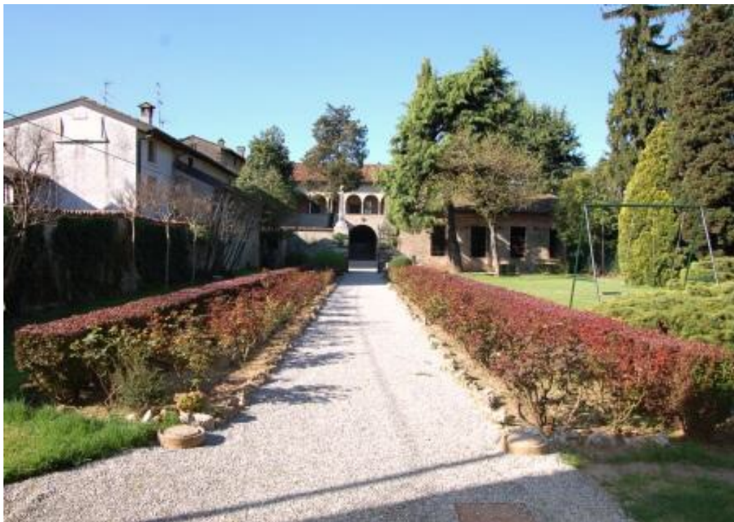
Castenedolo (BS) – Palazzo Belpietro ristrutturazione edilizia
