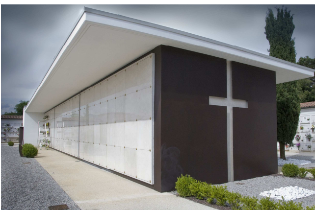
Ampliamento Cimitero Polpenazze del Garda
