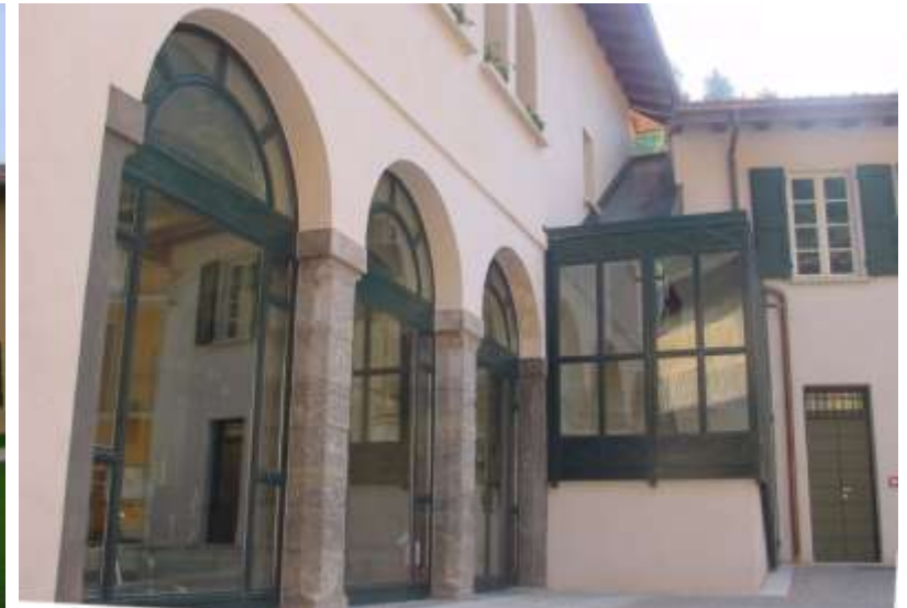
Tavernole Sul Mella, Palazzo Municipale, restauro ed ampliamento
