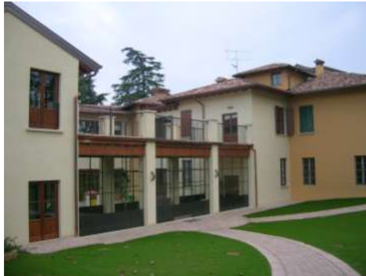
Calvagese, Villa Sertoli da Ponte, Asilo, restauro ed ampliamento
