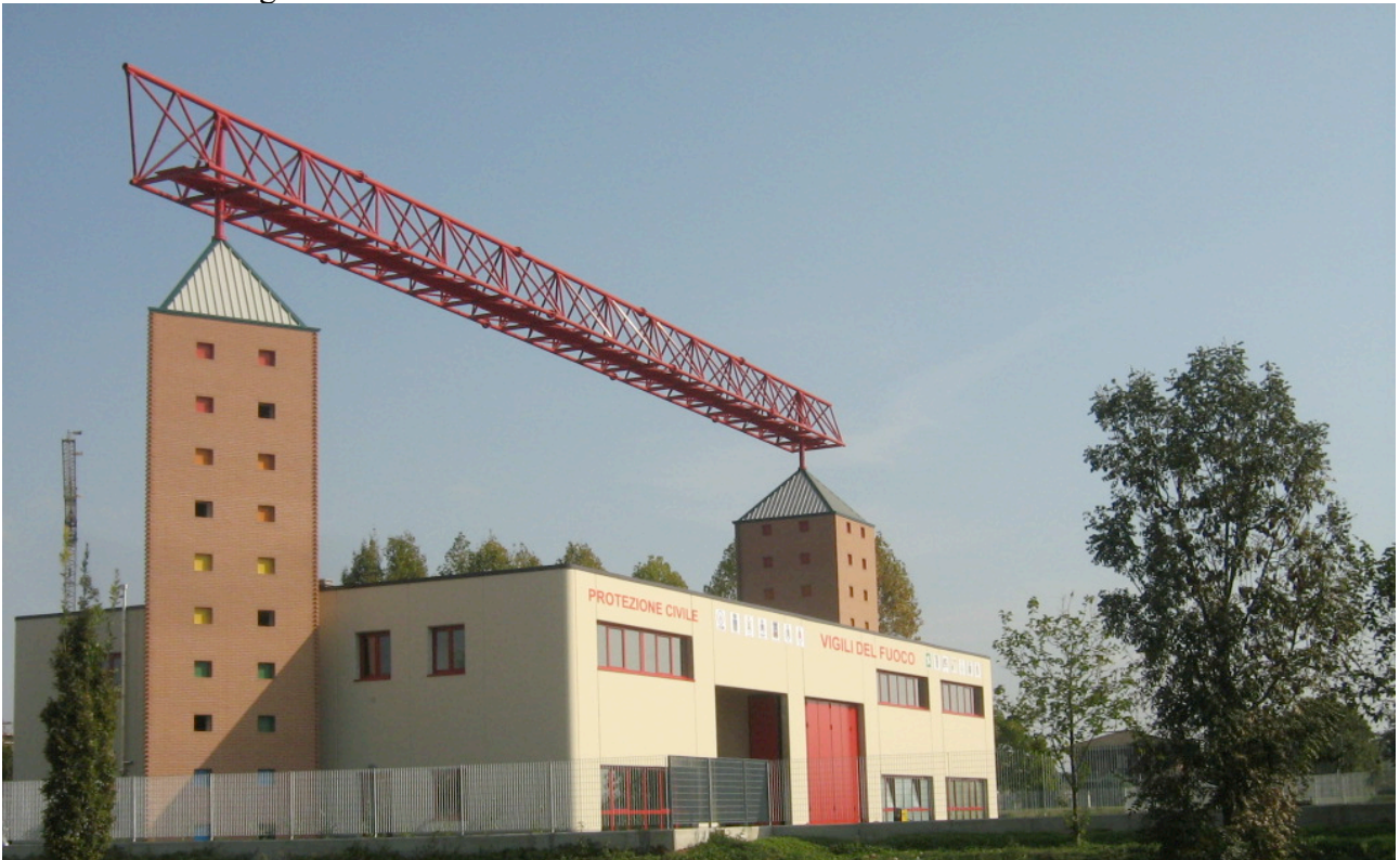
Nuova sede dei Vigili del Fuoco e della Protezione Civile a Chiari - Ottobre 2009-
